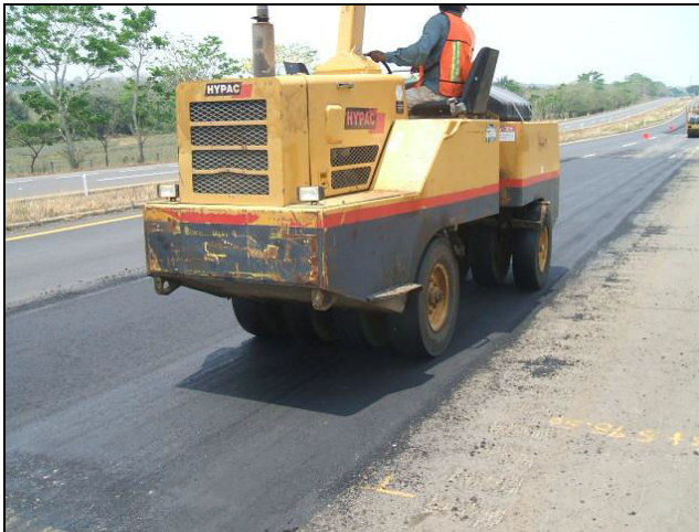
Fotografía 12.- Compactación de carpeta asfáltica con compactador de neumáticos.
