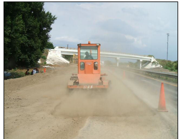
Fotografía 8.- Barrido de la capa de base previo al riego de liga.
