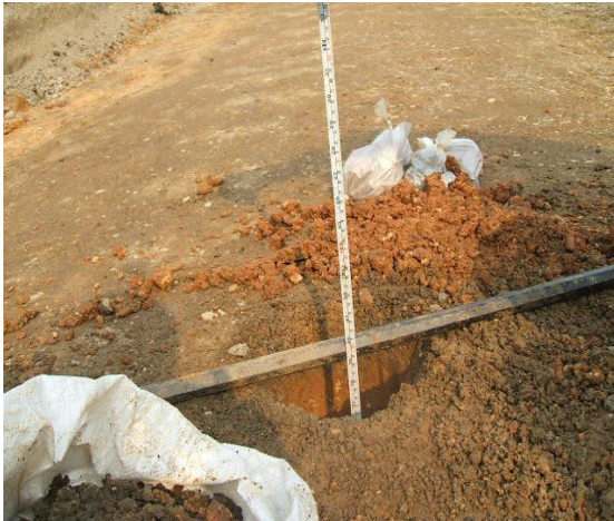
Fotografía 5.- Determinación del grado de compactación a una profundidad de 20 cms.
