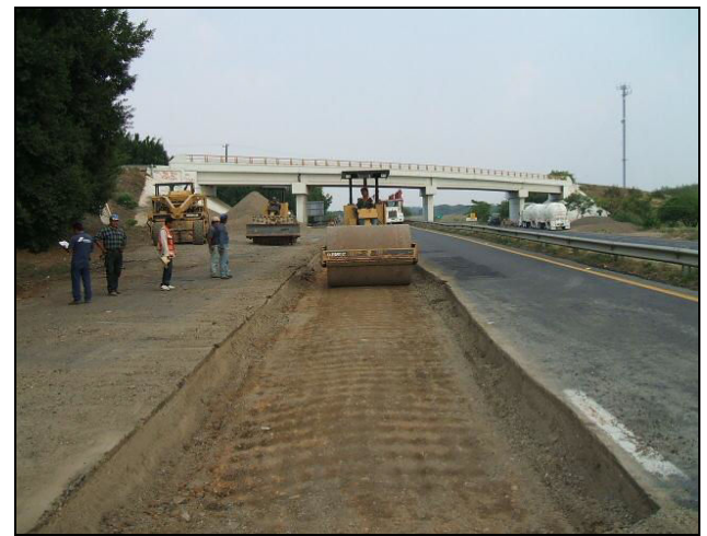
Fotografía 4.- Compactación de la superficie descubierta con vibrocompactador liso.
