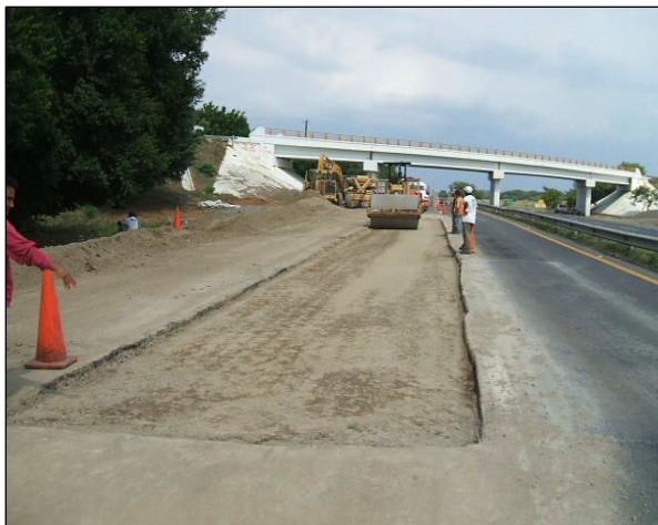
Fotografía 7.- Compactado de la capa de base hidráulica en un espesor de 30 cm.
