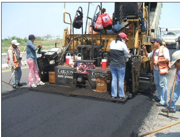
Fotografía 11.- Colocación de carpeta asfáltica con finisher.
