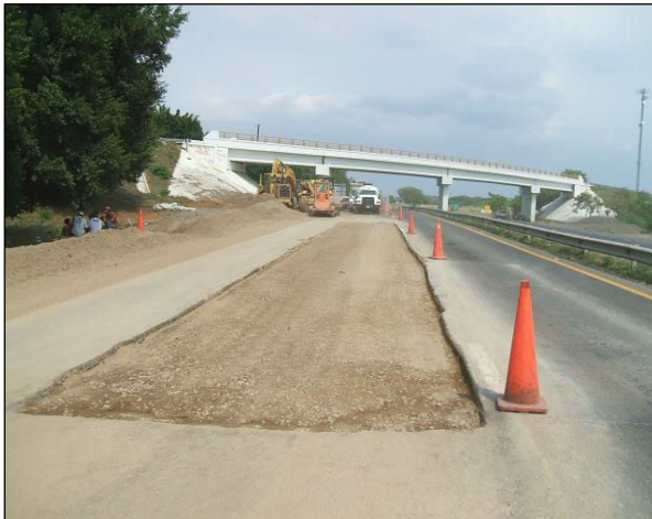
Fotografía 9.- Capa de base después de barrido lista para recibir el riego de liga.
