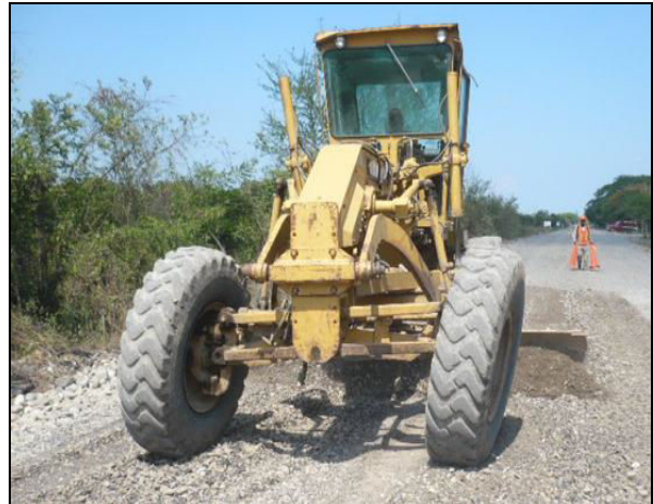
Fotografía 6.- Tendido de la capa de base hidráulica en un espesor de 30 m.
