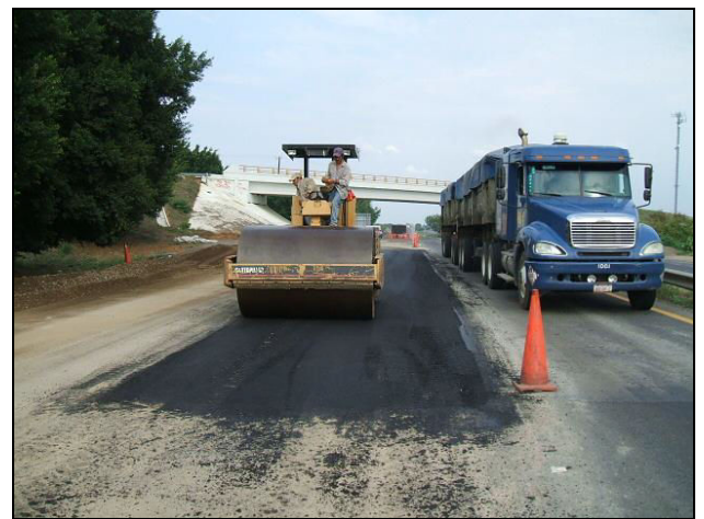
Fotografía 12.- Compactación de carpeta asfáltica con compactador liso.
