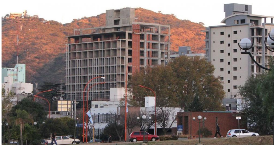
Figura 23: edificio de departamentos en construcción en Carlos Paz.
