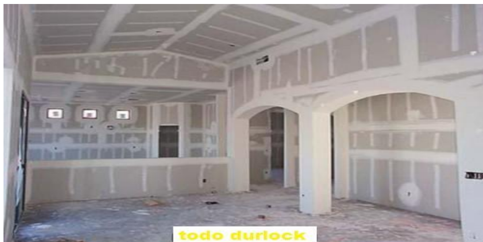
Figura 1: construcción en seco.
