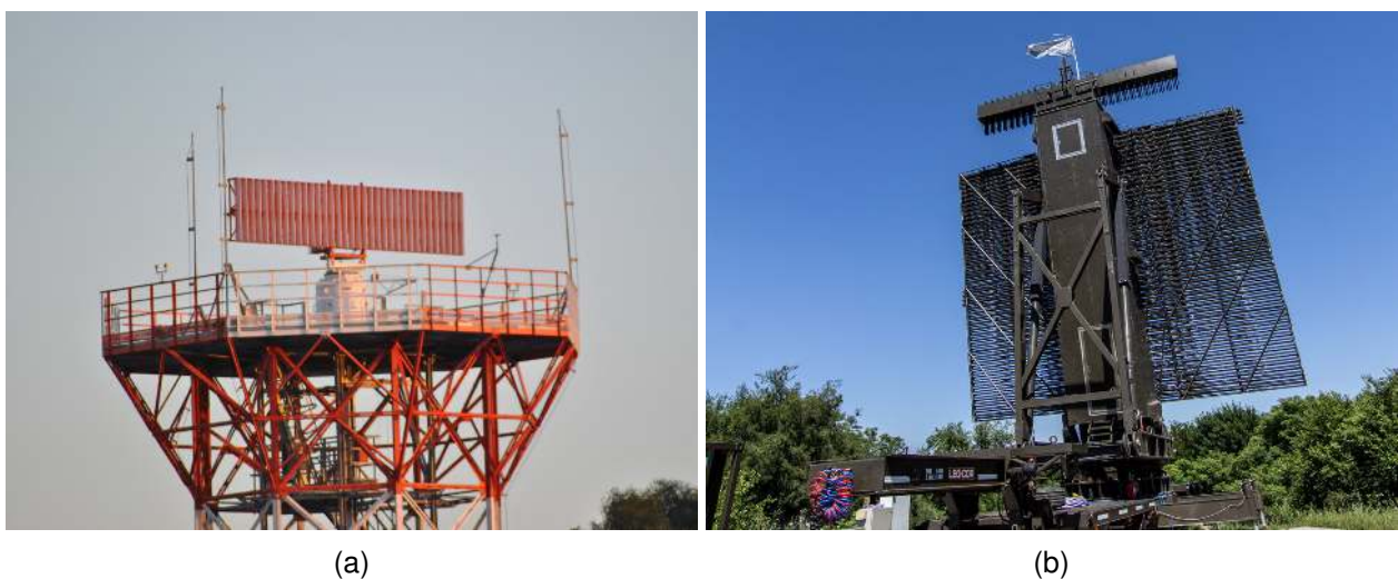
Figura 2.2: (a) Radar de Vigilancia Secundario Inkan instalado en el aeropuerto Ambrosio Taravella, Córdoba, Argentina (b) Radar Primario Argentino 3D
