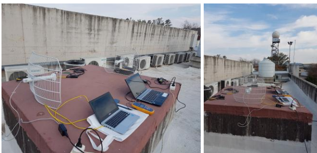
Fig. 5. Vista de los equipos en funcionamiento.
