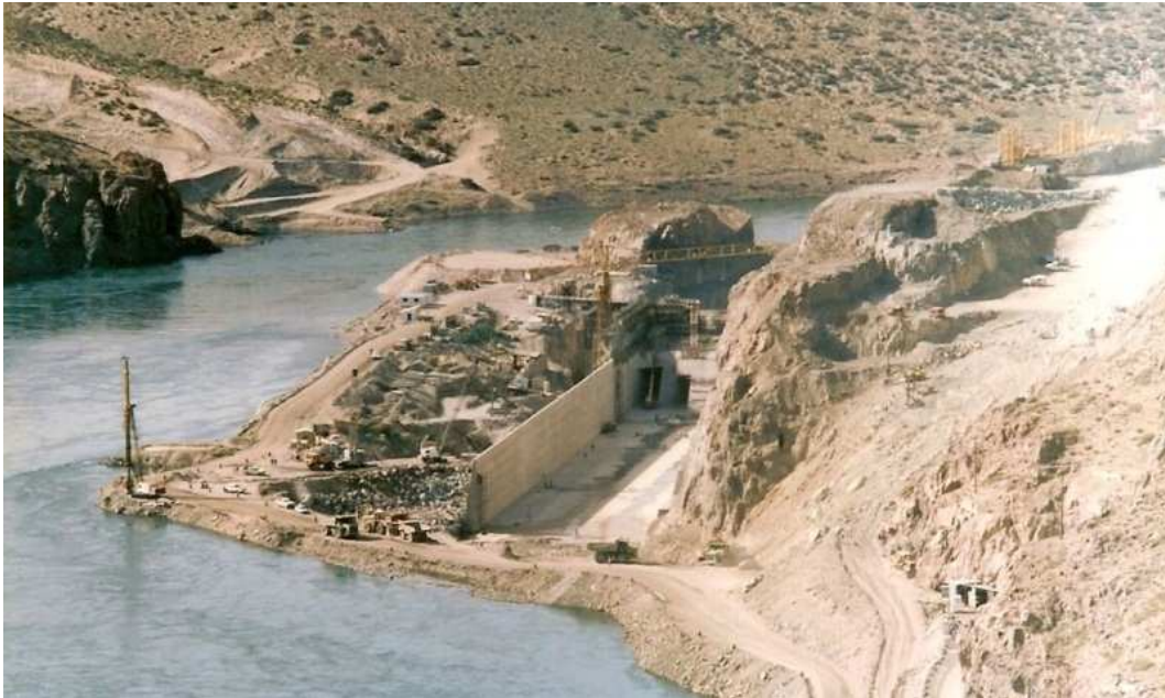
Figura N° 19 Construcción de obra de desvío
