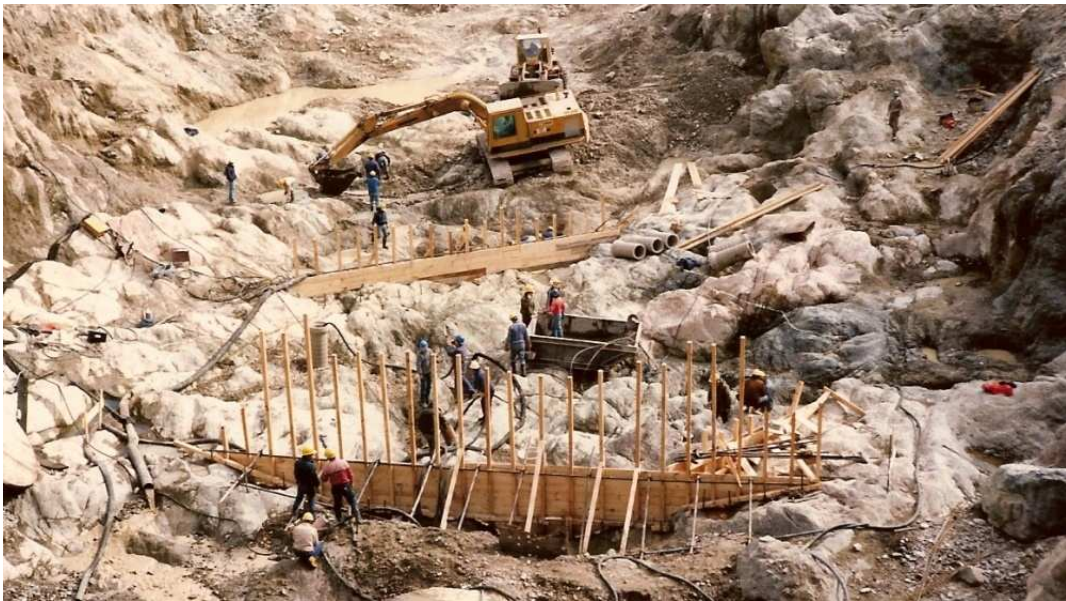
Figura N° 22 Acondicionamiento de la superficie de apoyo de los módulos.
