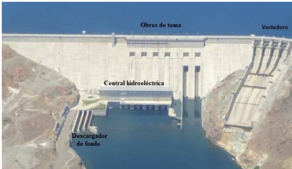
Figura N° 4 Infraestructuras de la Presa HPDA
