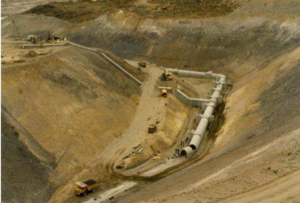
Figura N° 7 Excavación de la trinchera drenante al pie del Paleocauce.
