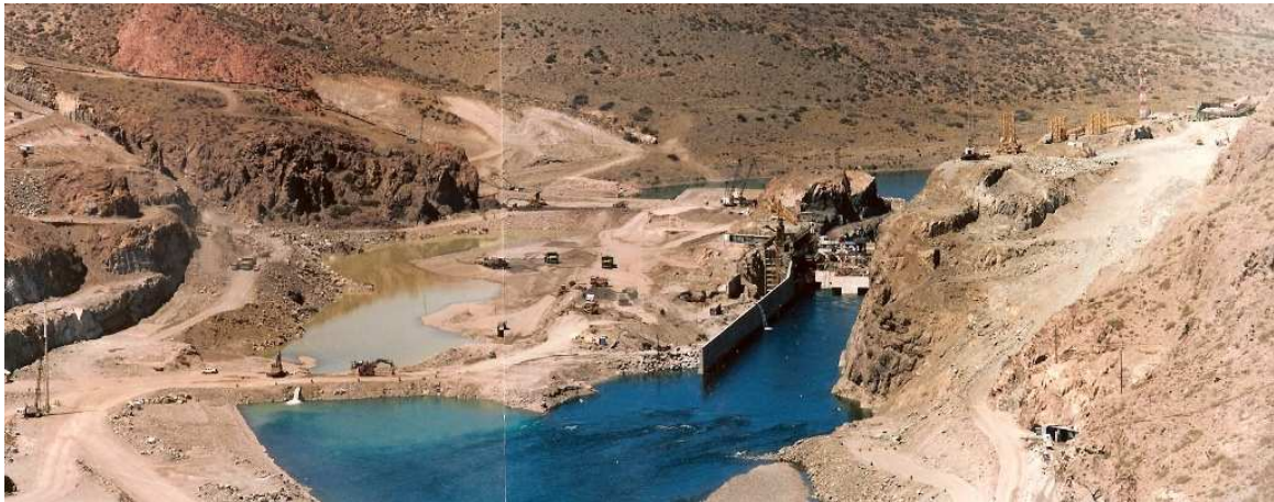
Figura N° 20 Desvío del cauce del Río
