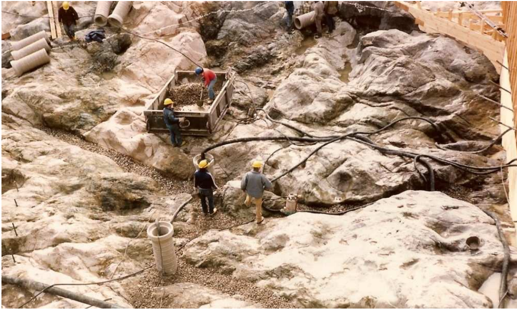
Figura N° 23 Instalación de Piezómetros en contacto con el módulo.
