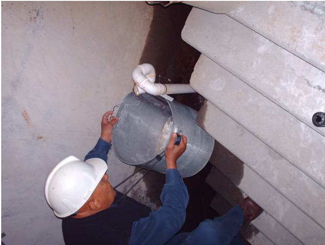
Figura N° 13 Medición de caudal en Drenes
