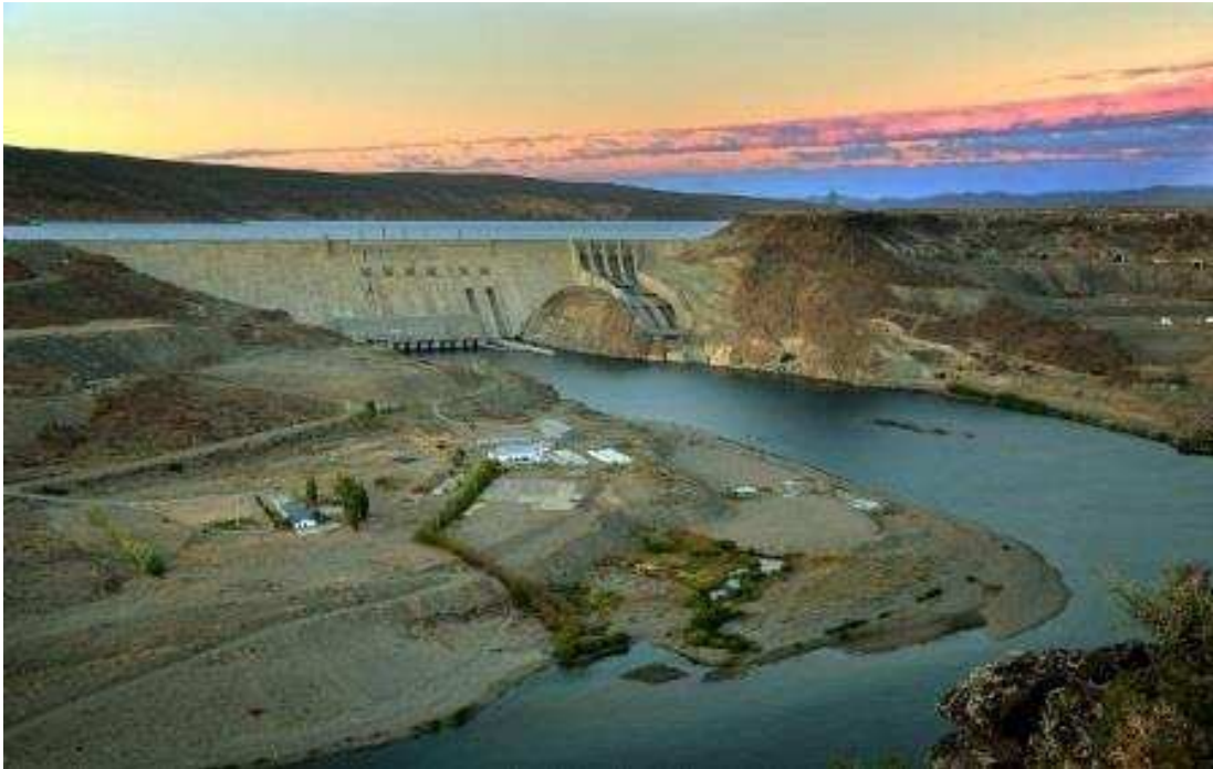
Figura N° 2 Presa de la Central HPDA
